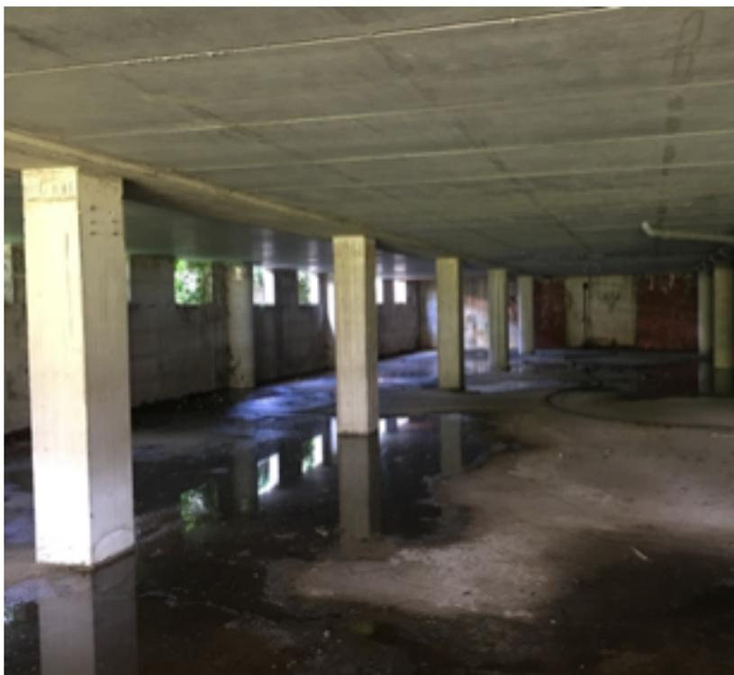
All'interno l'edificio si presenta totalmente al rustico, privo di impianti, con parte dei tavolati di divisione realizzati ma che potrebbero dover essere demoliti e nuovamente ricostruiti per adattare gli spazi alle esigenze dei nuovi utilizzatori. Anche in questo caso verranno realizzati i lavori per migliorare la classe energetica adeguandola ai migliori standard richiesti al momento dal mercato per ottenere un prodotto oggi unico nel Cremasco.
